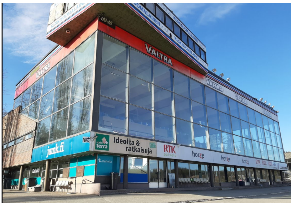
Kuva 1. Killerin raviradan vanha katsomorakennus (Paasu-Hynynen 2020)
