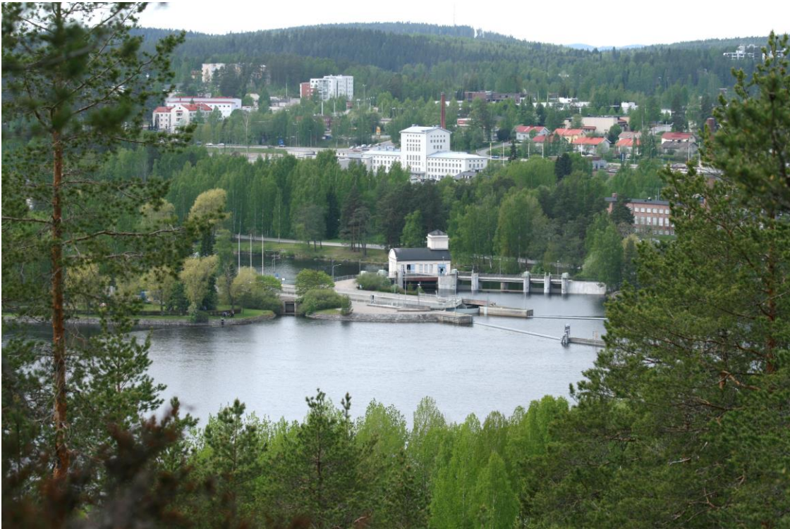
Kuva 5 Kanavuoren näköalapaikoilta voi nähdä muun muassa vanhan vesivoimalaitoksen
