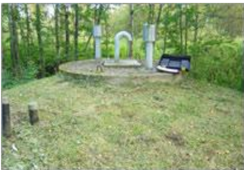
Hyvässä kaivossa tuuletus toimii ja kansi on kunnossa (Kuva: Vesikaivuhuolto VIPE Oy).
