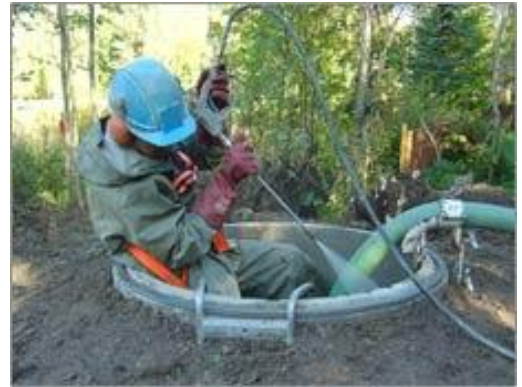
Kaivoa huollettaessa on muistettava huolehtia työturvallisuudesta (Kuva: Vesikaivuhuolto VIPE Oy).
